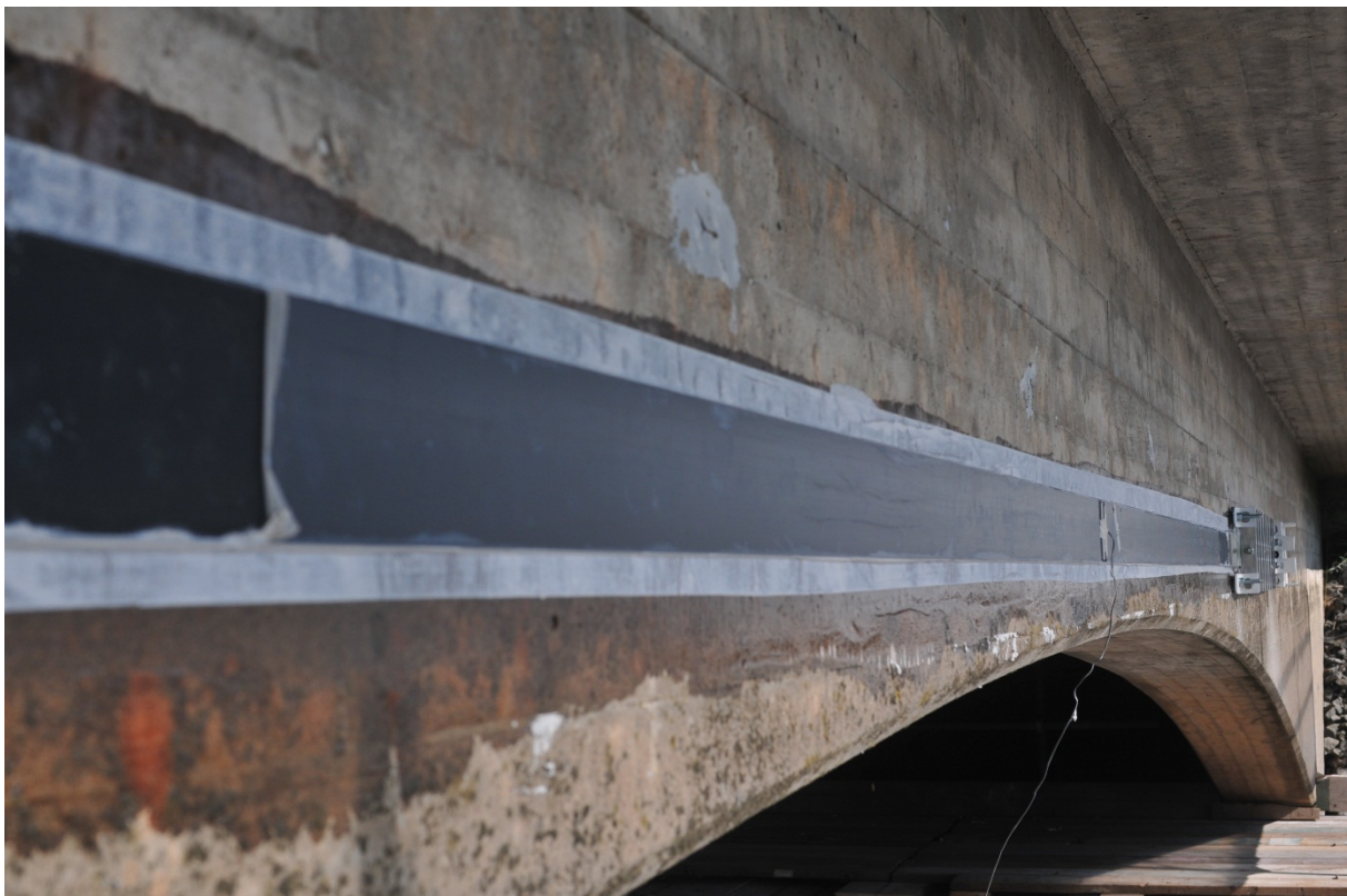
Förstärkning av bron över Nossan med den nya förspänningsmetoden
